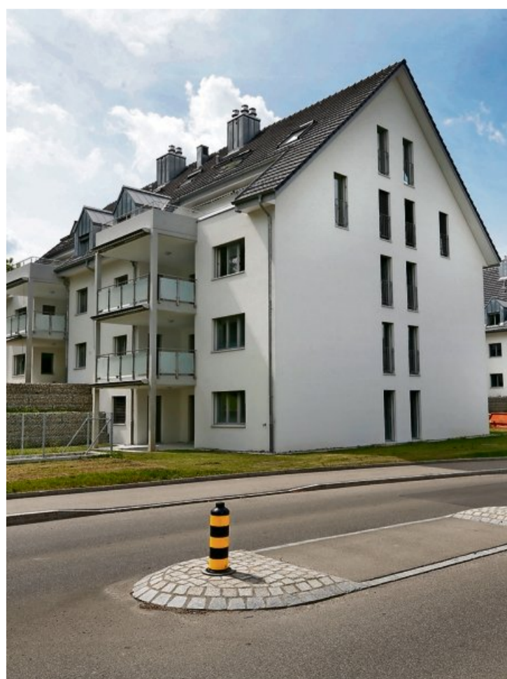
Die Wohnungen am Burgweg in Steinmaur sind nach über sechs Jahren Bauzeit bezugsbereit.
